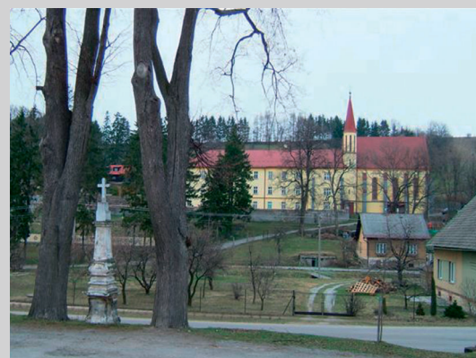
Das Kloster inklusive Kapelle - in diesem Kloster wurde die Wärmepumpe durch die Kesselkaskade VERNER ersetzt, die in dazugehörigem Objekt situiert sind.
