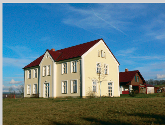
Das Familienhaus, Bauernhaus - Kesselraum ist in einer selbstständigen Gebäude inkl. weiterer Nebenräume situiert (Autounterstand, Werkstätte, Keller ...)
