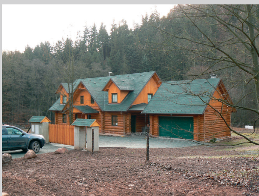
Der Holzblockhaus - Kesselraum (inkl. Brennstofflager) ist in einem gemeinsamen Objekt mit der Garage situiert
