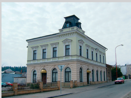
Das Bürohaus - der Kesselraum ist im Erdgeschoss der Gebäude situiert, in ähnlichen Objekte wurden aber auch die Kesselräume in dem Dachboden realisiert
